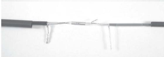
Наденьте среднюю термоусаживаемую трубку 8/2, 100 мм поверх кабеля DSWB.
