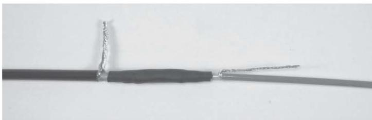
Надвиньте маленькую термоусаживаемую трубку 4/1, 35 мм поверх сделанного соединения, отцентрируйте ее относительно соединительной гильзы и усадите ее, начиная с середины и постепенно передвигаясь к концам.
