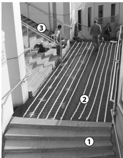
В этом примере зоны подогрева поверхности располагаются на ступенях снизу (1) и сверху (3) и на дорожке (2) между ними. В зависимости от количества Зон и требуемой надёжности системы можно установить 2-3 датчика Грунта.
