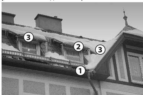
**Датчик №1** следует устанавливать в затенённой стороне. Важно, чтобы стекающая с поверхности кровли вода в первую очередь попадала на датчик, а затем стекала в желоб. Если снег будет сползать к краю кровли, место установки датчика должно выбираться таким образом, чтобы оно высыхало последним.
