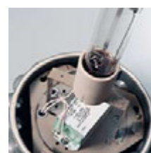
Установка лампы
