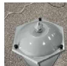
Крепление крышки светильника
