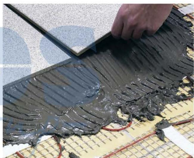
Работы, связанные с нанесением плиточного клея, требуют соблюдения определенного температурного режима (от +5 °C до +25 °C). Это требование относится как к температуре основания, так и к воздушной среде. Аналогичный температурный режим должен сохраняться и на протяжении времени, необходимого для отвердения плиточного клея. Проследите за тем, чтобы во время проведения указанных работ в помещении не было сквозняков.
