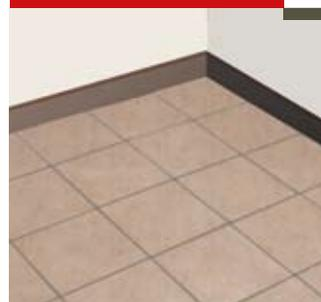
Закончив укладку, герметизируйте силиконом стык плитки со стеной. До включения системы обогрева необходимо дождаться полного высыхания и отвердевания клея.
