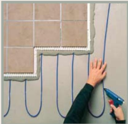
Гибкий греющий кабель, идеально подходящий для устройства тёплого пола в помещениях небольшой площади и сложной конфигурации. Предназначен для укладки под плитку или натуральный камень.
