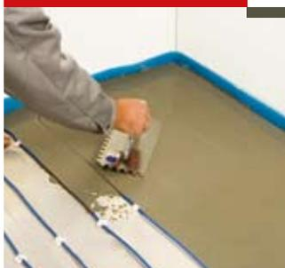
Аккуратно распределите шпателем самовыравнивающую смесь, полностью закрыв кабель. Дождитесь полного высыхания и отвердевания в соответствии с инструкцией производителя.
