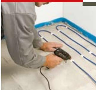
Надежно зафиксируйте кабель на чистом и сухом основании (например, с помощью клеевого пистолета). Для улучшения адгезии рекомендуется нанести на основание слой грунтовки.
