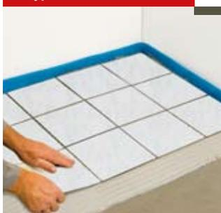
Равномерно распределяя клей, уложите плитку и заделайте швы. Во влажных помещениях сначала необходимо нанести слой гидроизоляции, а затем наносить клей для камня.
