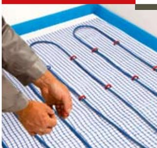
Прежде чем начинать монтаж греющего кабеля, определите площадь пола, подлежащую обогреву. Согласуйте эти данные с проектировщиком / дизайнером и специалистом по установке стяжки. Рассчитайте шаг укладки кабеля и надежно зафиксируйте его на поверхности во избежание возможного смещения. При укладке на металлическую сетку используйте хомуты KBL-10. На ровной чистой поверхности удобно использовать клеевой пистолет с термопластиковыми стержнями.
