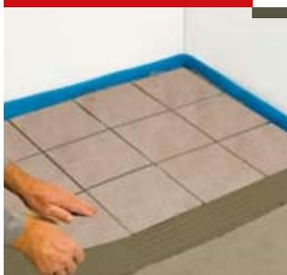
Нанесите слой плиточного клея, уложите плитку. Во влажных помещениях до укладки плитки сначала нанесите слой гидроизоляционного покрытия. После полного отвердевания заделайте швы между плитками.
