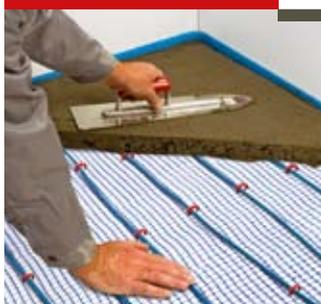
Аккуратно, стараясь не повредить греющий кабель, нанесите цементную стяжку (самовыравнивающую смесь). Следует дождаться полного набора прочности в соответствии с инструкцией производителя.
