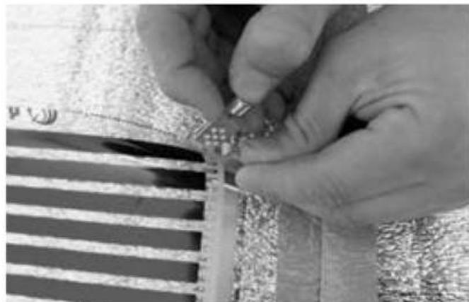
5.11 Изолируйте место соединения при помощи битумной изоляции (2 отрезка). Поместите контактную группу строго по центру изоляции и зажмите её с 2-х сторон, как показано на фото 3.
