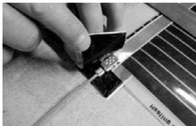
5.12 Заизолируйте линии отреза токоведущей шины в местах, где не установлены зажимы (фото 4).
