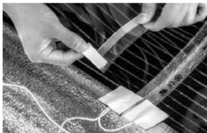
5.13 Подготовьте в полу углубление (ориентировочно 10 мм) для датчика температуры. Уложите в углубление кусочек теплоизоляции таким образом, чтобы датчик не соприкасался с основным полом (это необходимо для корректной работы датчика). При помощи монтажной ленты закрепите датчик на нижней стороне нагревательной плёнки. Датчик должен располагаться под чёрной полоской (углеродный нагревательный элемент). Прорежьте в теплоизоляции отверстия под сам датчик и проводку.
