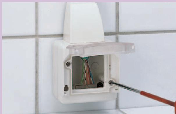
После крепления переходника Кат. № 303 34 защелками на кабель-канале, установите переходник Mosaic Кат. № 917 90 и затем закрепите винтами
