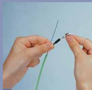
6 Надеть защитный капюшон для завершения подключения. Монтаж завершён.
