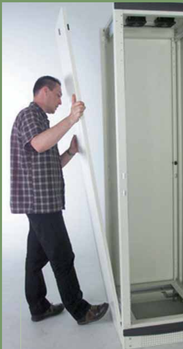
■ Демонтаж боковых панелей
