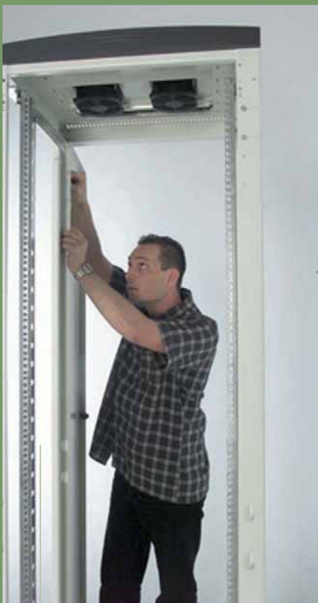
■ Демонтаж задней двери
