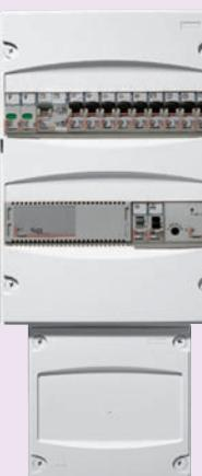
Блок питания устанавливается в электрощите; батарея устанавливается в отдельный щиток, расположенный под щитом
